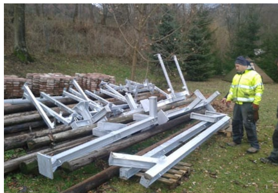
• Konštrukcia v demonte
