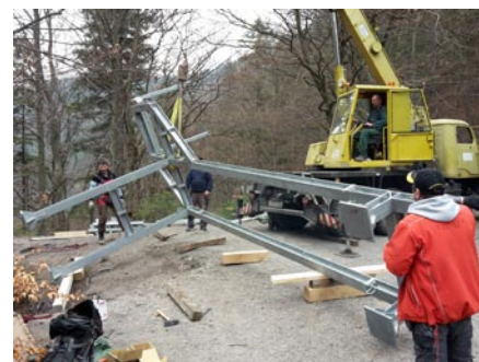
Stavba vyhlídky v Kvačianskej doline
